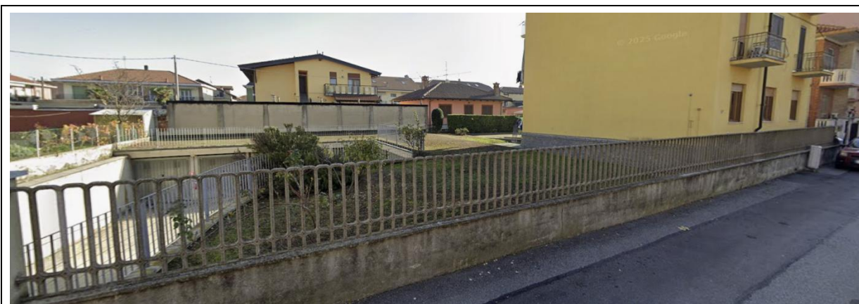
Vista del lotto da via Rivoli
