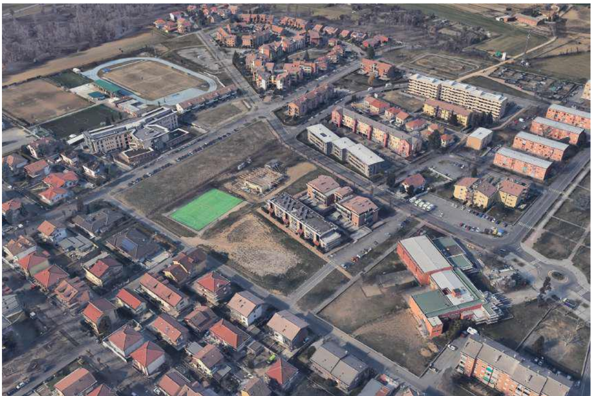
Foto aerea angolo sud-est
