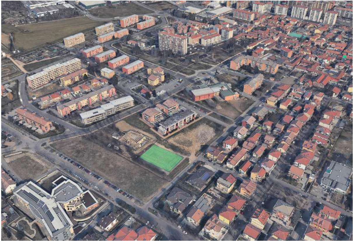
Foto aerea angolo sud-est
