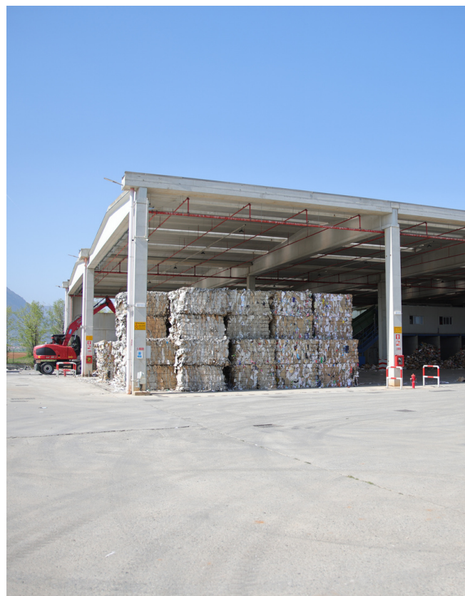
Impianto di selezione della carta Pessacollo, Piossasco
