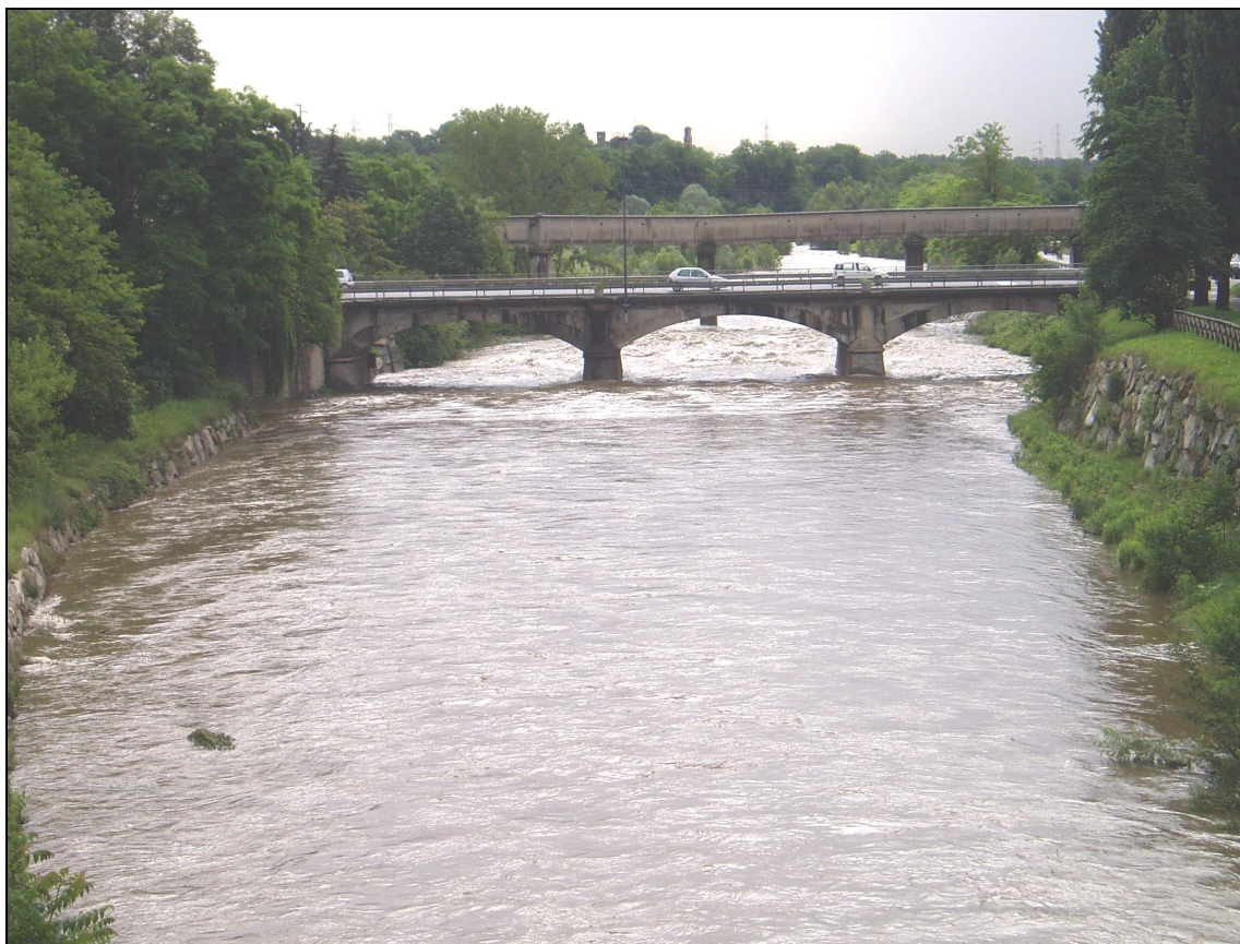
Figura 2-8. Ponte stradale della S.P. Torino – Orbassano che attraversa il T. Sangone in territorio di Beinasco.
